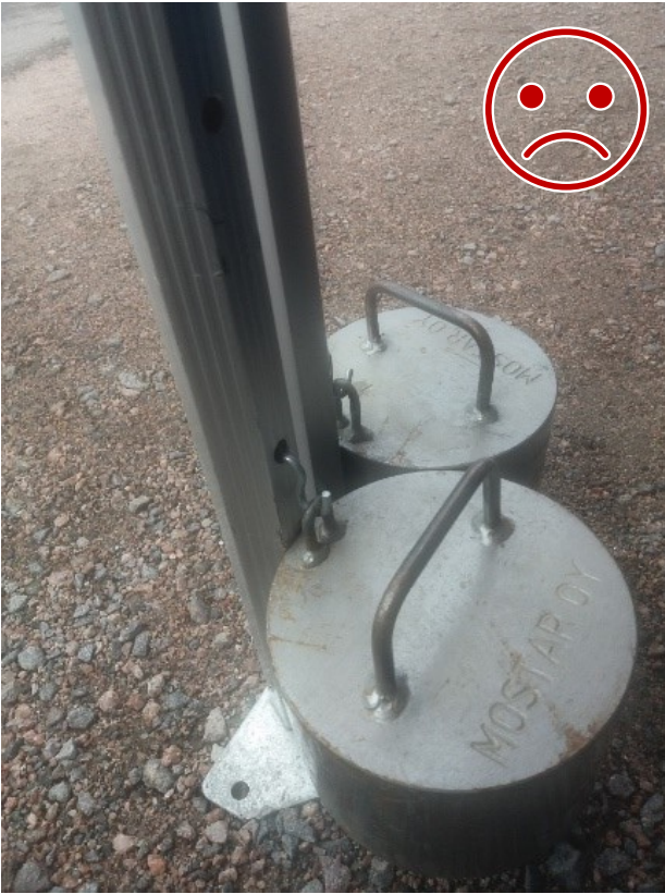
Kuva 9 EI NÄIN. Teräskoukku ei lukkiudu rakenteeseen. Lisäksi teräs leikkaa alumiinia nosteen ravistellessa telttää.
