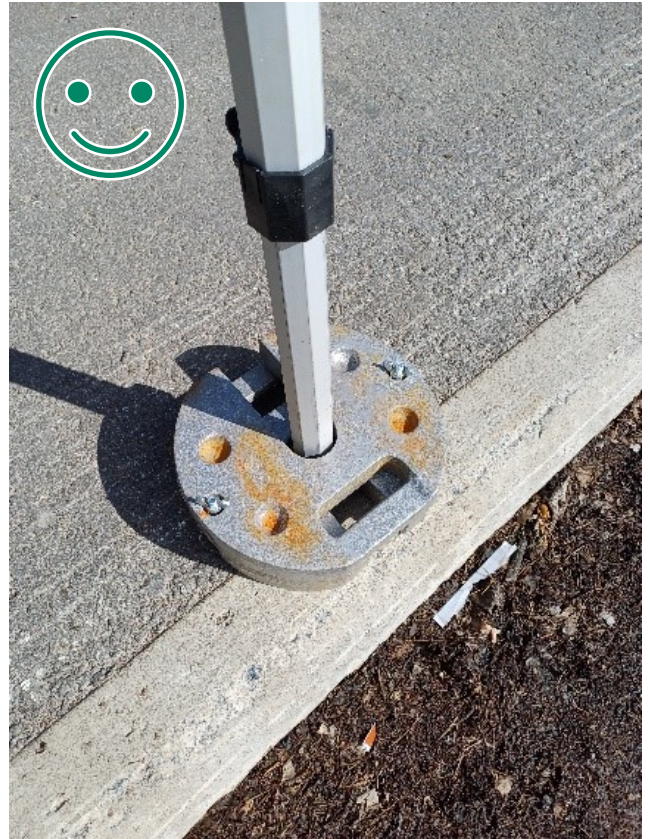
Kuva 2 HYVÄ TAPA. Molemmat painot kiinnitetty siipimutterilla molemmin puolin. Hevosenkenkäpainot vastakkain, jolloin tolppa ei pääse irtoamaan rakenteen liikuessa. Kulmatolpan maajalan tulee kestää kyseinen paino.
