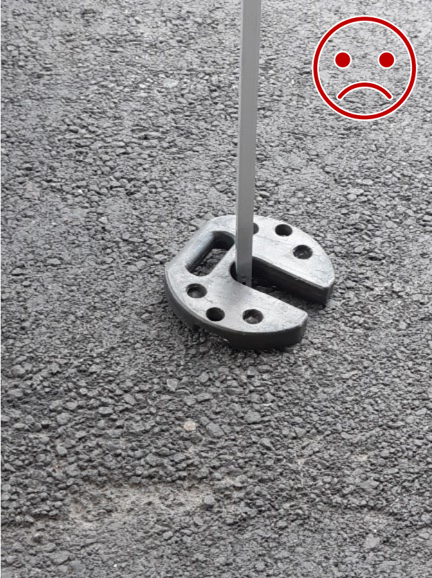
Kuva 3 EI NÄIN. Painoa ei ole lukittu rakenteeseen. Toinen paino päälle toiselta puolelta sekä painojen lukitseminen myös toisiinsa on tarpeen.
